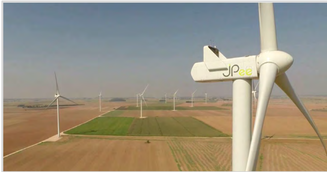
PHOTO 1 - PHOTOGRAPHIE DU PARC EOLIEN DU MOULIN D'EMANVILLE
